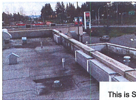
A EXISTING CORNER PARAPET SCALE: 1/8"
